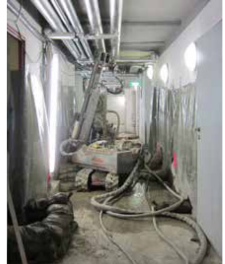
Bild 9: Düsenstrahlverfahren im Kellergeschoss mit kompaktem Bohrgerät
