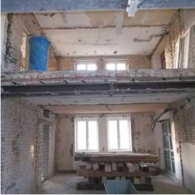
Bild 11: Taktung des Deckenaustausches
