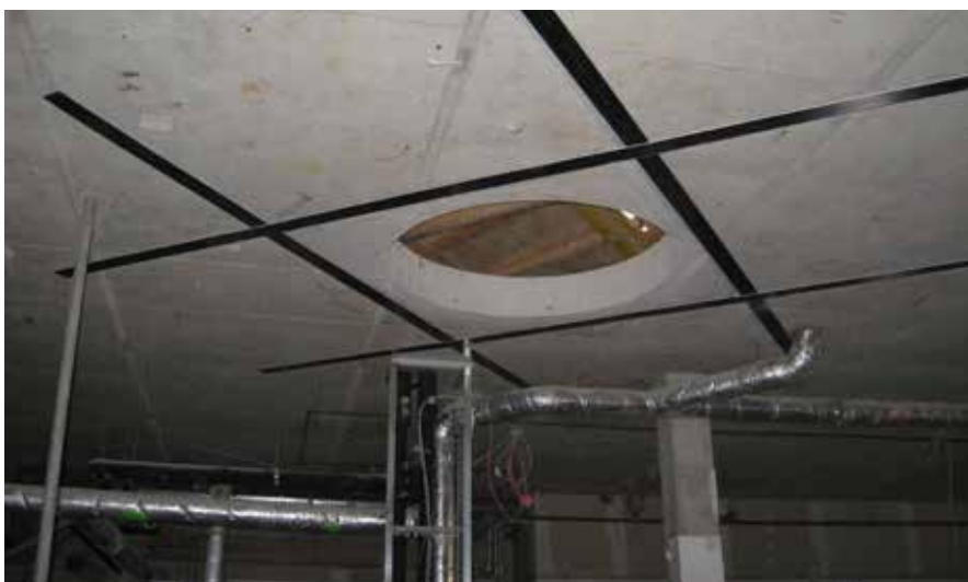
Bild 7: CFK-Lamellen zur Bauteilertüchtigung am nachträglich eingeschnittenen Oberlicht
