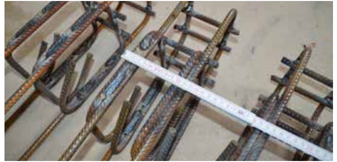
Bild 12: Module der geschweißten Konsolbewehrung
