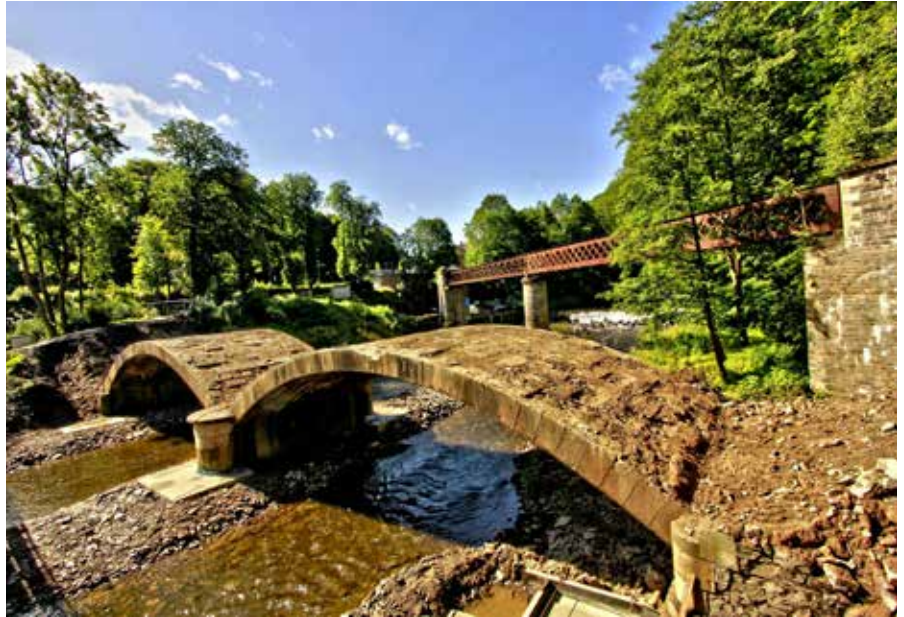
Bild 2: Freigelegtes Bogentragwerk
