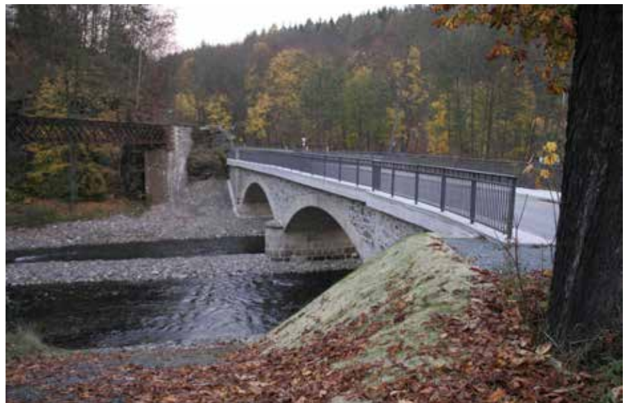
Bild 6: Oberstromseitige Ansicht des fertigen Bauwerkes
