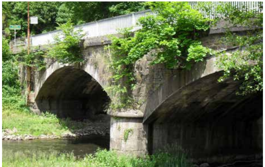
Bild 1: Bestandsansicht Oberstrom vor Instandsetzung
