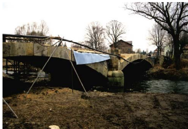
Fig.4: Straßenbrücke mit Kreisbögen und konischen Bögen (Bauzustand)
