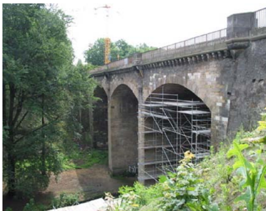
Fig. 3: Straßenbrücke mit Kreisbögen und konstanter Bogendicke
